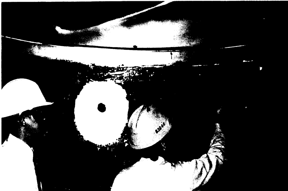
尾管穴蝕處以倍造耐、塑膠鋼填補(廠家建議改以焊補修整)
