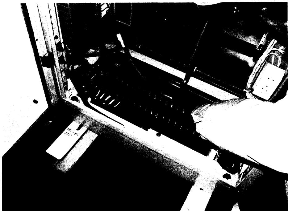
照片五 Melco 盤面增加儀控接地匯流排設計(I-Bus Bar)
