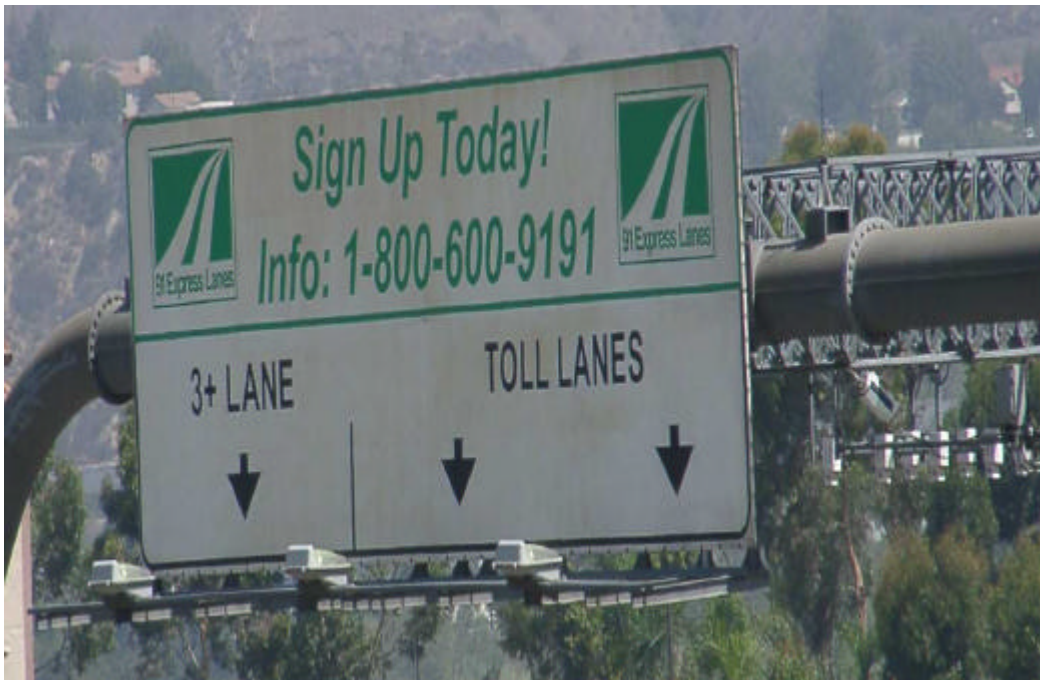
電子收費設備
