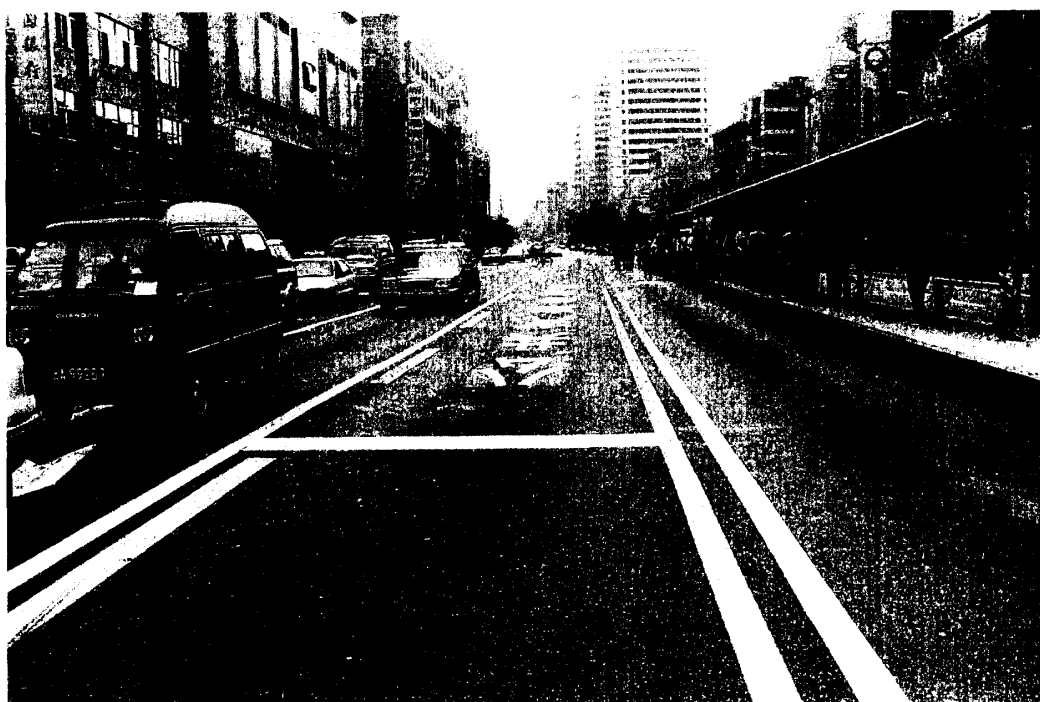
昆明市公車專用道標線規劃(單邊允許變換車道、停止線退縮)
