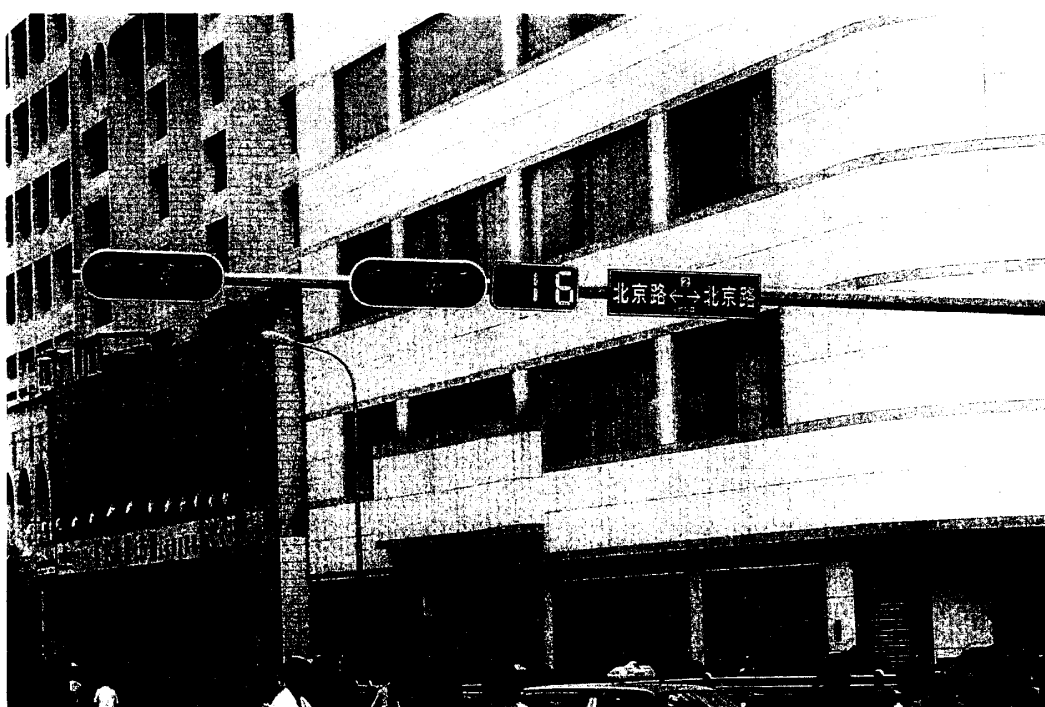
昆明市 LED 式行車管制號誌與倒數計時燈號
