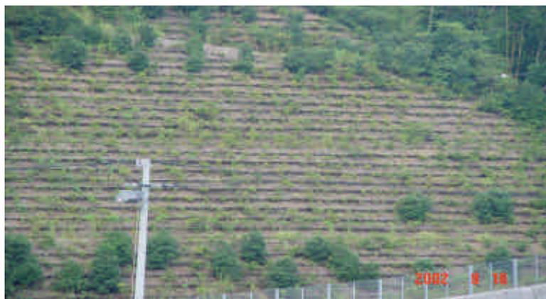
圖 2 崩場地編柵工於栽植 1 年後之情形
