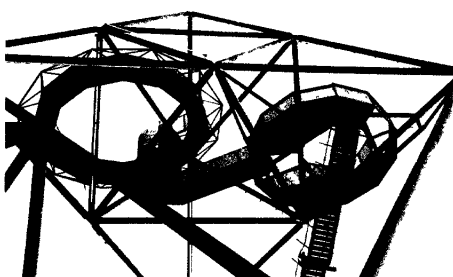
圖 8-2 煤渣山頂設計一個金字塔型的四面體鋼結構，目前成為一個重要的地標。
