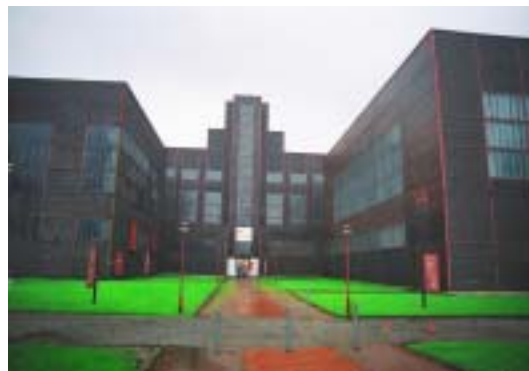
圖 6-2 工業設計展覽中心為更新案的核心，透過國際競圖遴選出英國籍的建築師 Norman Foster 將鍋爐機房改造為工業設計展覽中心。
