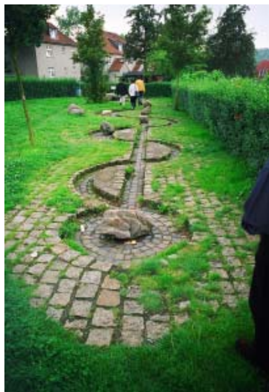
圖 10-5 配合蘭佛河流域的整治設計特殊的雨水自然排放系統
