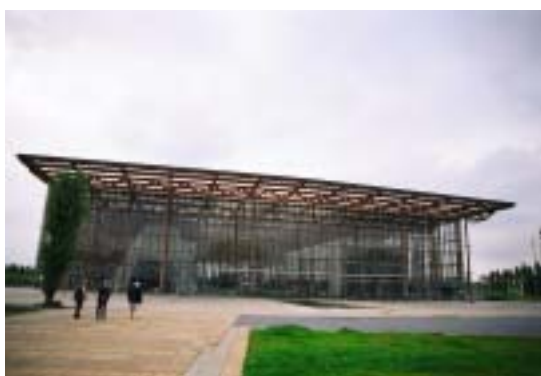
圖 7-5 蒙特—仙尼士的屋頂有一半面積安裝了太陽能板，其太陽能的發電量為單一建築物之冠。
