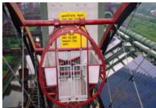
圖 6-6 原有運煤設施重新再利用為供民眾使用的摩天輪設施
