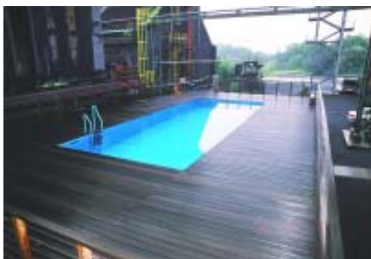
圖 6-5 利用原有蓄水池改造為游泳池
