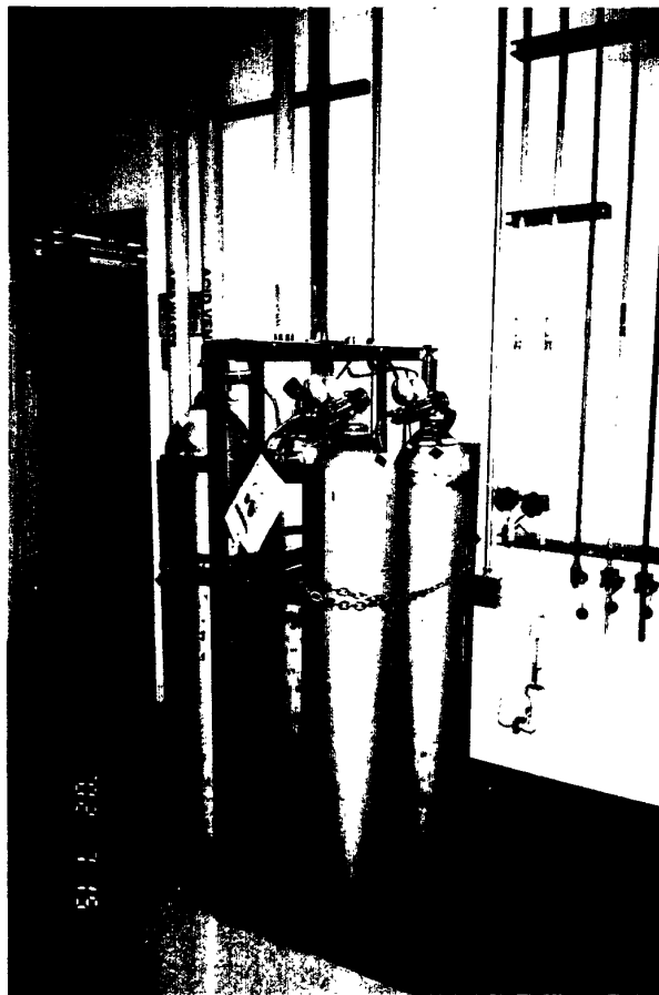
圖十五 實驗室走道上之氮氣鋼瓶及氣體管線
