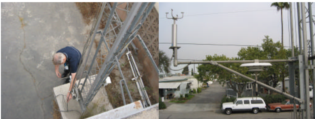
圖 13、加州南灣 AZUSA 空氣品質測站氣象監測鐵塔與儀器平台
