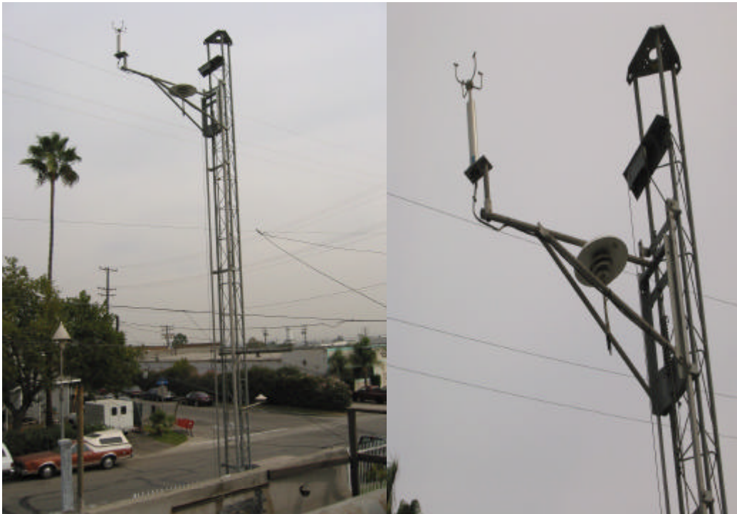
圖 12、加州南灣 AZUSA 空氣品質測站氣象監測鐵塔
