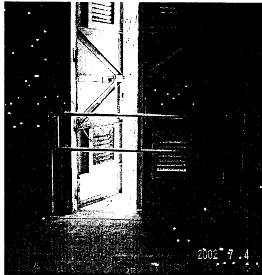
圖十一.HEC 位於二樓之配電室
