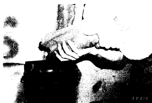
相片二：倒入熔接粉及銅粉
