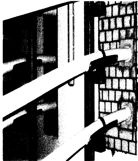
相片八：電纜穿過變電所牆壁
