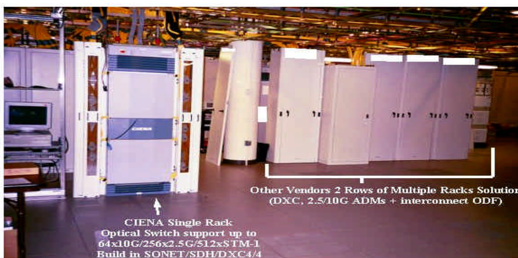
圖四-1 CoreDirector 設備與傳統 SDH 設備之機架空間比較
