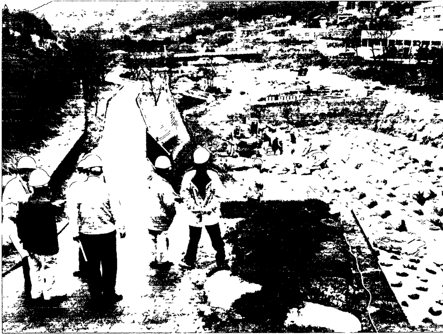
照片十五 中津川市湯舟澤固床工群立砌人造石魚道水路工
