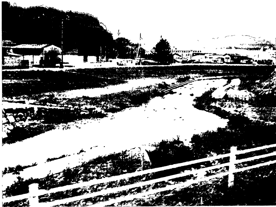
照片十四 野溪治理低水位砌大塊石護岸
