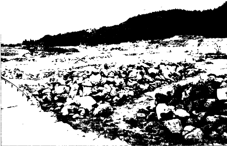
照片十七 中津川市四目川低水槽，兩岸設置複式高灘地滯洪區
