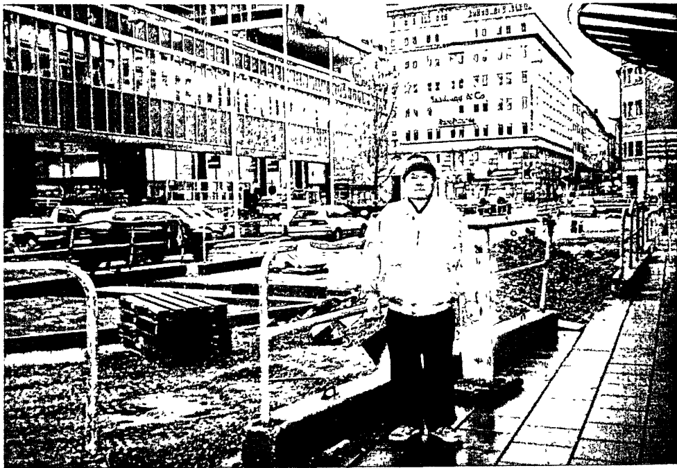
市區道路施做安全危籬
