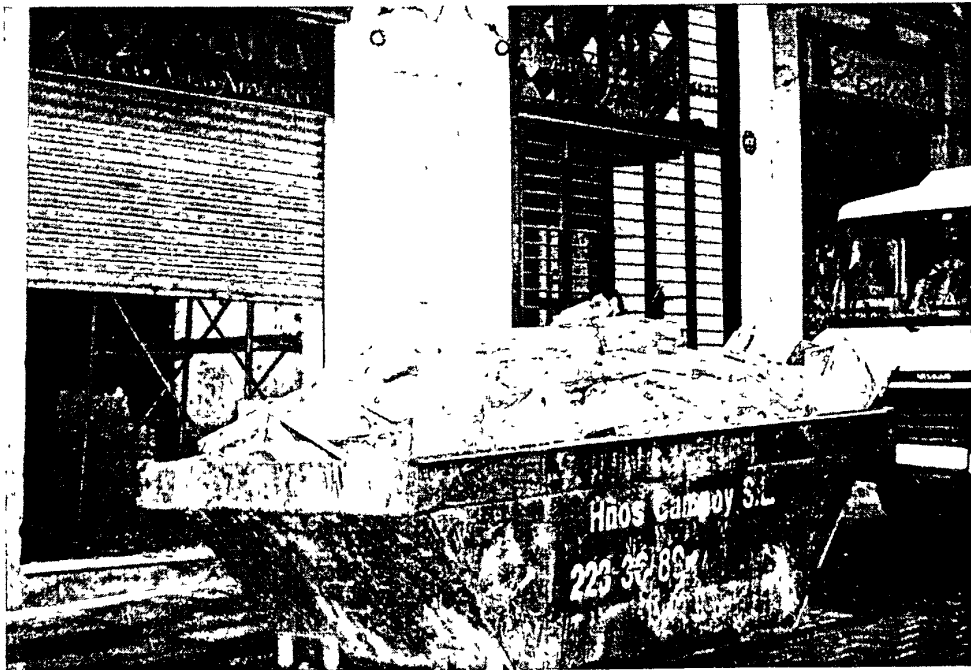
施工中廢棄物不落地
