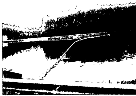
圖三：西雅圖公共供水公司以攔索防止微量浮油污染飲用水體
