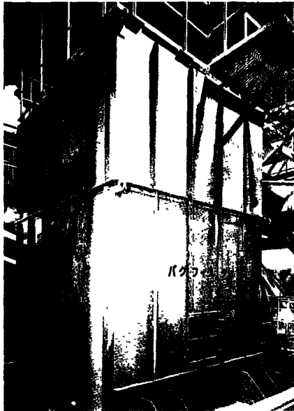
● バグフィルタ 各機器から発生する粉じんを集め、ろ布で捕集します。
