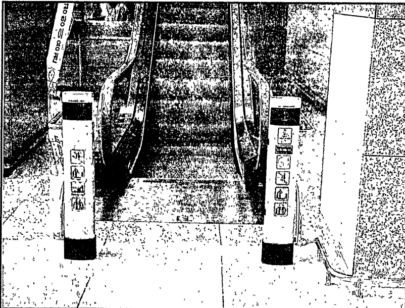
編號：仁川 25 說明：電扶梯入口
