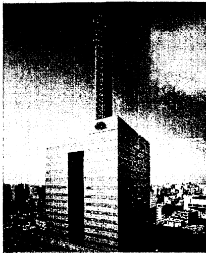
松枝變電所外觀
