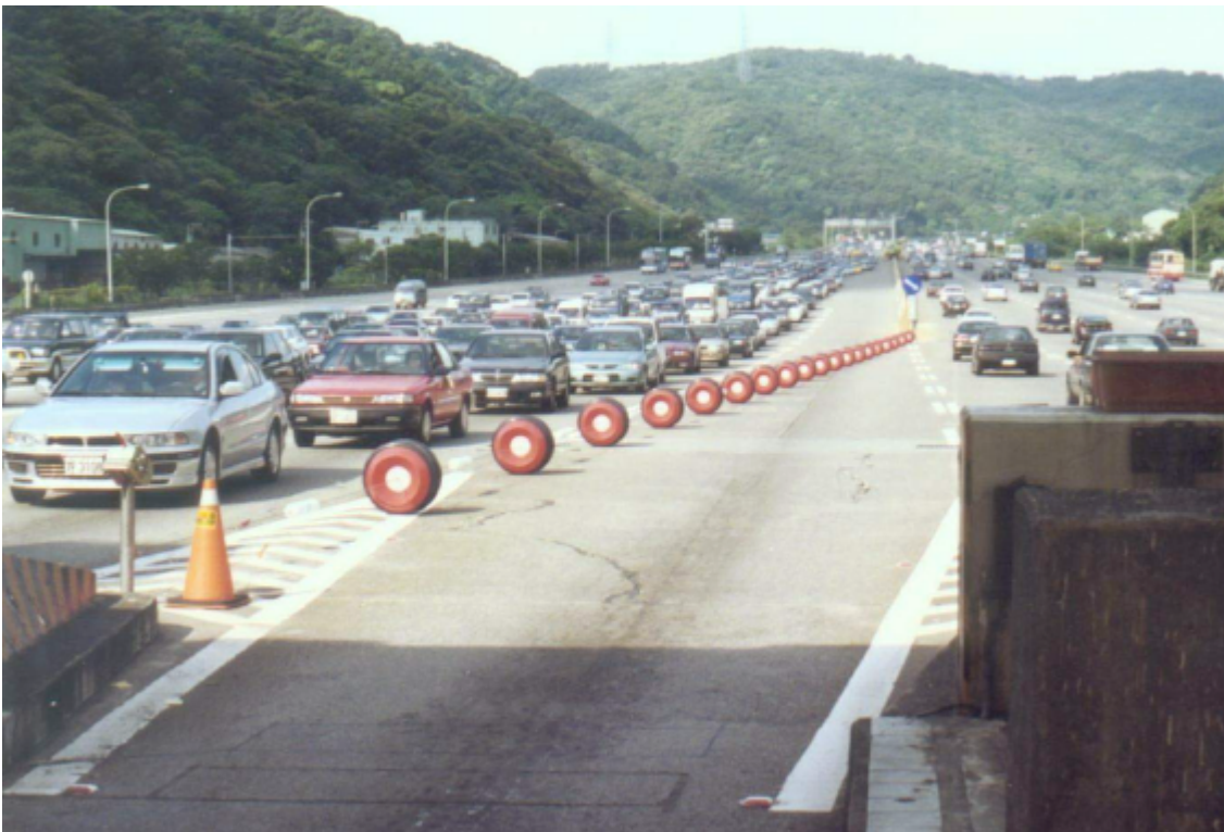
圖 3 高速公路泰山收費站輪軸式調撥車道設備
