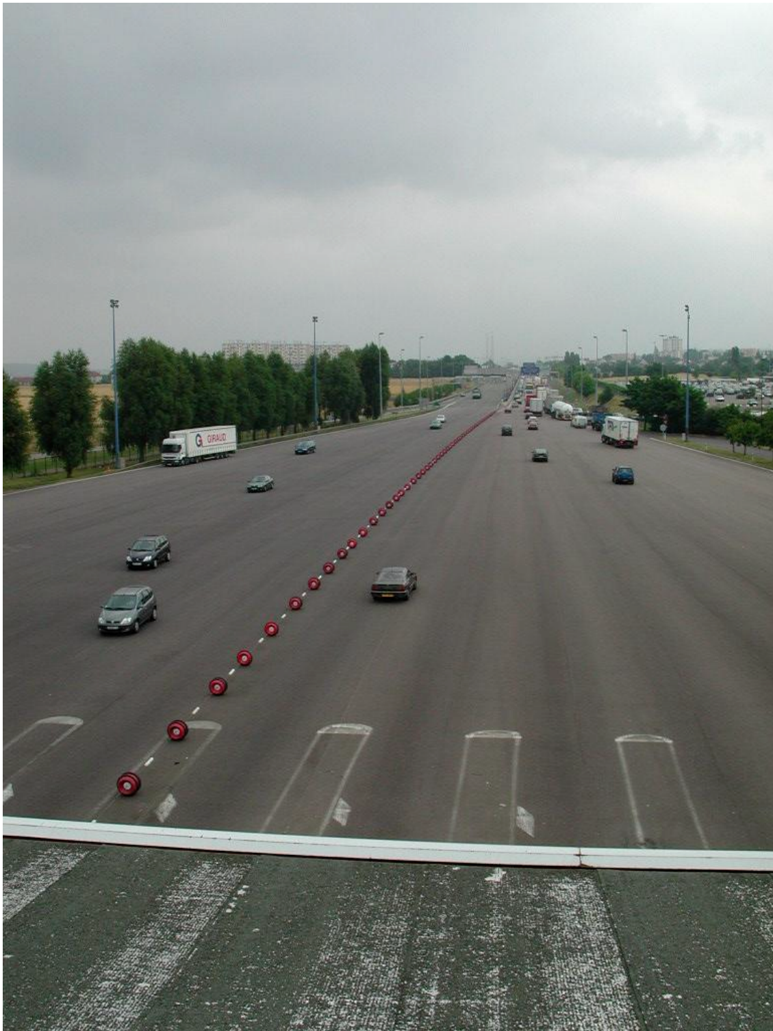
圖 5 法國高速公路收費站之輪軸式調撥車道設備
