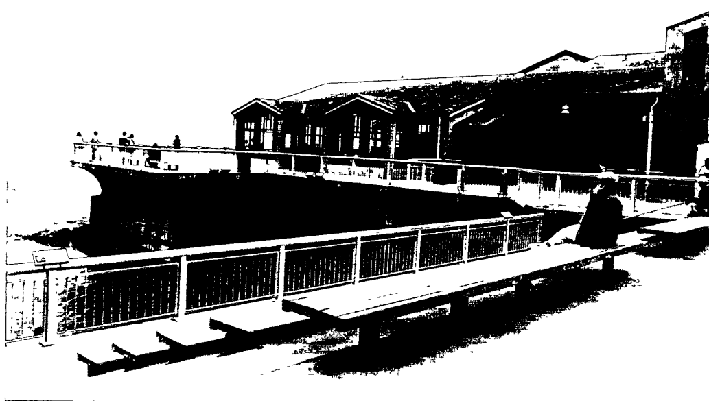
蒙特利灣水族館仍保有當年罐頭工廠之外形
