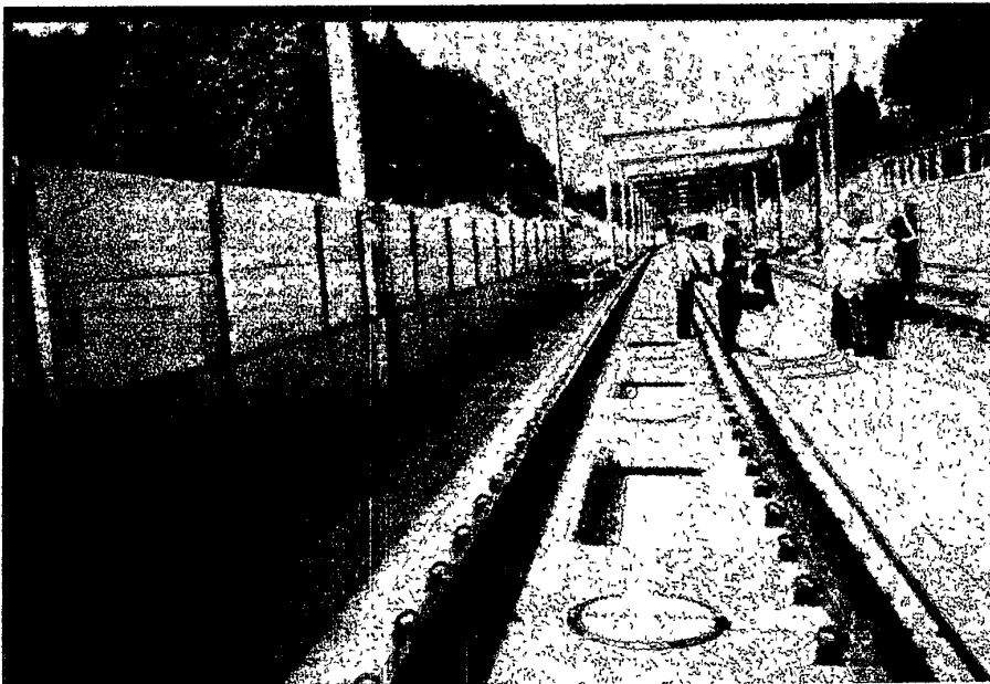
圖 4-16：非隧道土工路段上之框型版式軌道
