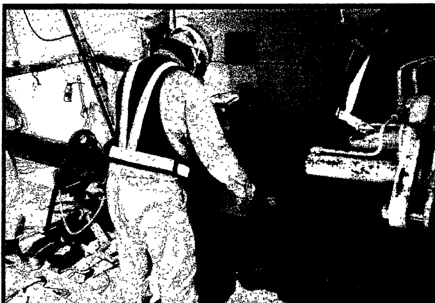
圖 4-5：鋼軌焊接
