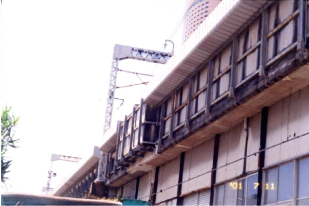
圖 3-3：具隔音箱之隔音牆
