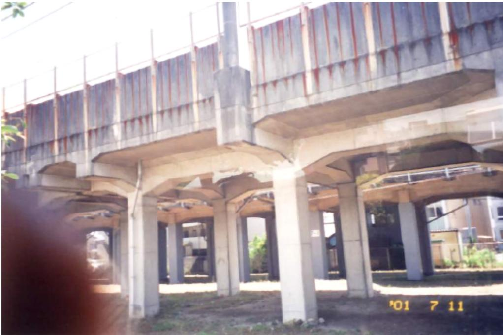
圖 3-2：早期（東海道）新幹線剛構架式高架結構及隔音牆
