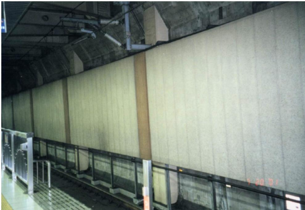
圖 3-8：上野新幹線地下車站之吸音牆
