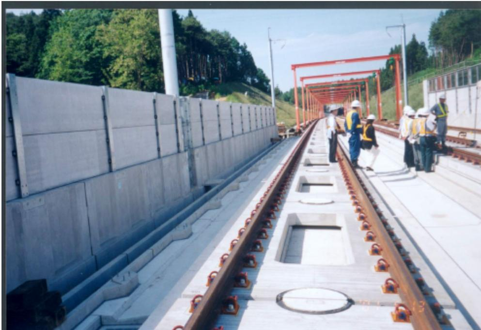
圖 4-16：非隧道土工路段上之框型版式軌道
