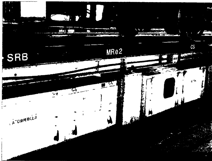
圖 3.1.5 檢修股道下之控制箱及電纜箱
