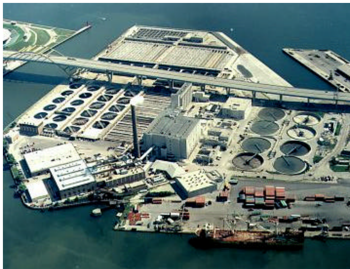
Jones 島廢水處理廠
