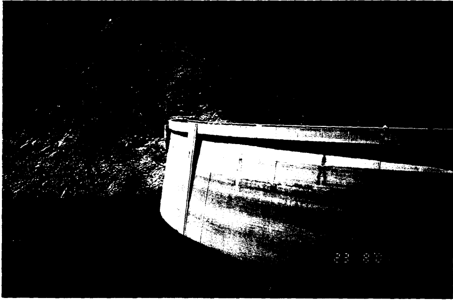
Canyon Dam 拱壩施工情形相當完美
