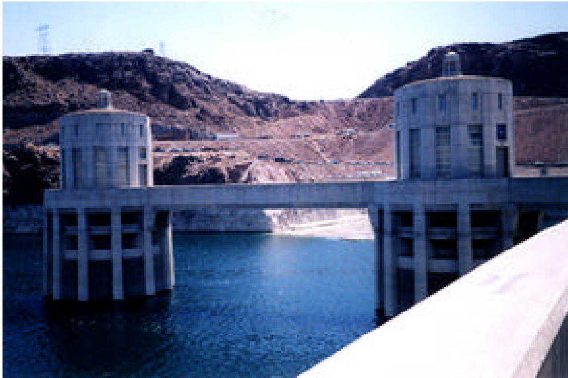
Hoover Dam 塔式取水口
