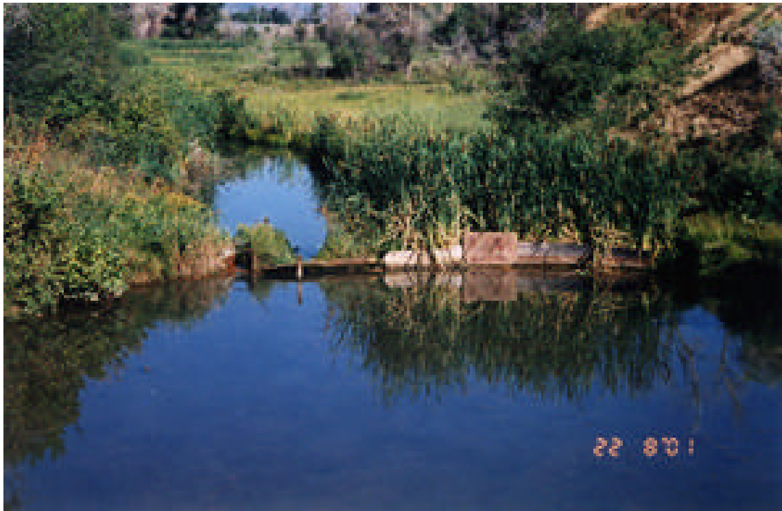
Echo Dam 大壩下游面簡易滲漏水量測設施
