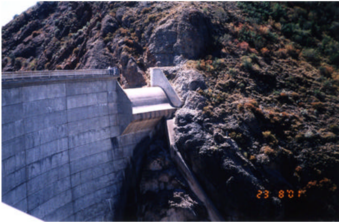
Canyon Dam 無閘門溢洪道
