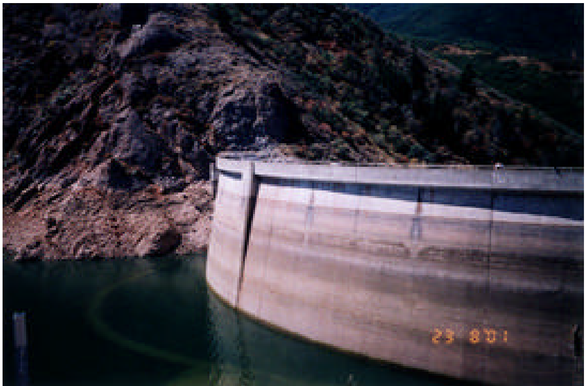
Canyon Dam 拱壩施工情形相當完美
