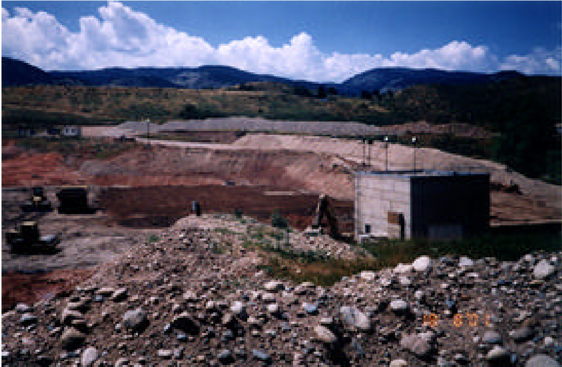
Horseteeth Dam 補強（下游坡增設 berm）
