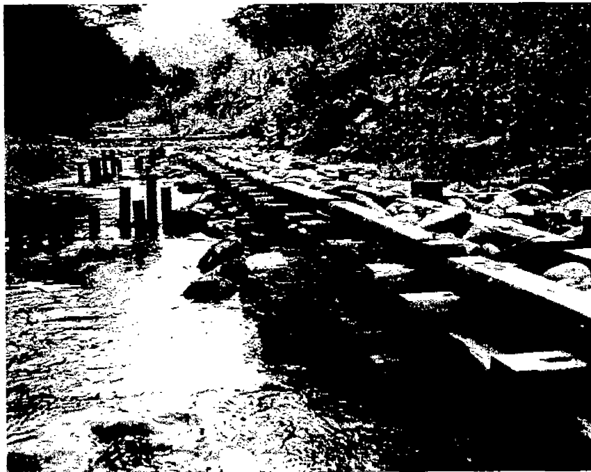
Fig.92 間伐材在溪澗穩固工程之應用
