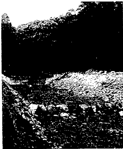
Fig.100 支笏湖溪流以災害現場石塊堆砌護岸
