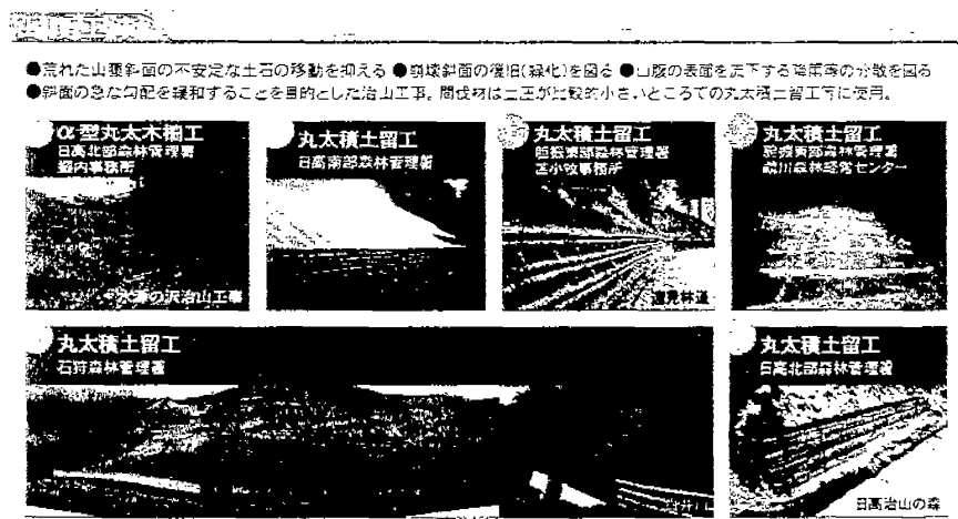
Fig.89 間伐材在邊坡穩固工程之應用
