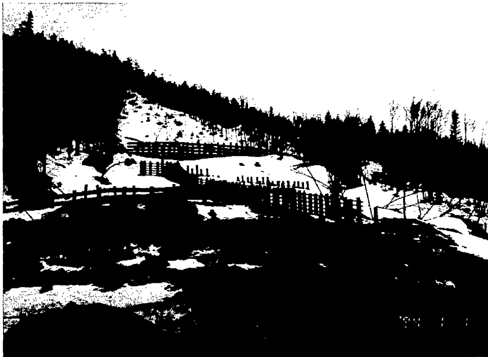
Fig.94 札幌市近郊定山溪薄別川崩塌坡面穩固及攔導處理
