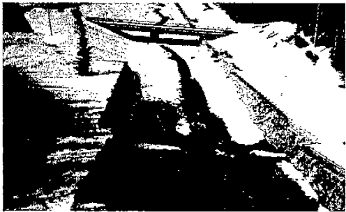
Fig.8 火碎流、土石流之導流道
