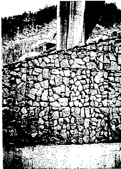
Fig.23 橋墩以混凝土灌漿後外部再以石材堆砌美化
