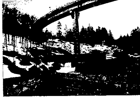
Fig.19 (左)、20 (右) 札幌市—中山峠間 230 國道無意根高架橋橋墩基礎加強及邊坡河岸穩固施工
