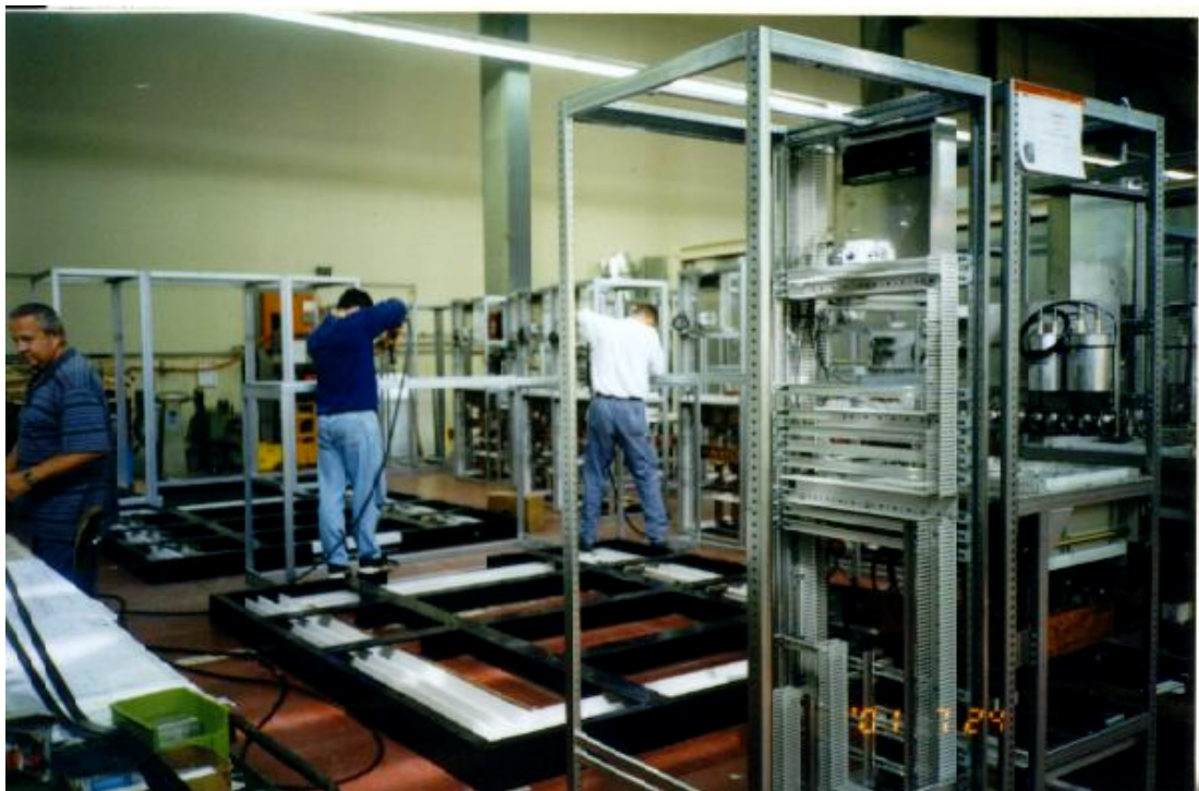
#2Excitation Cubicle 框架安裝。
