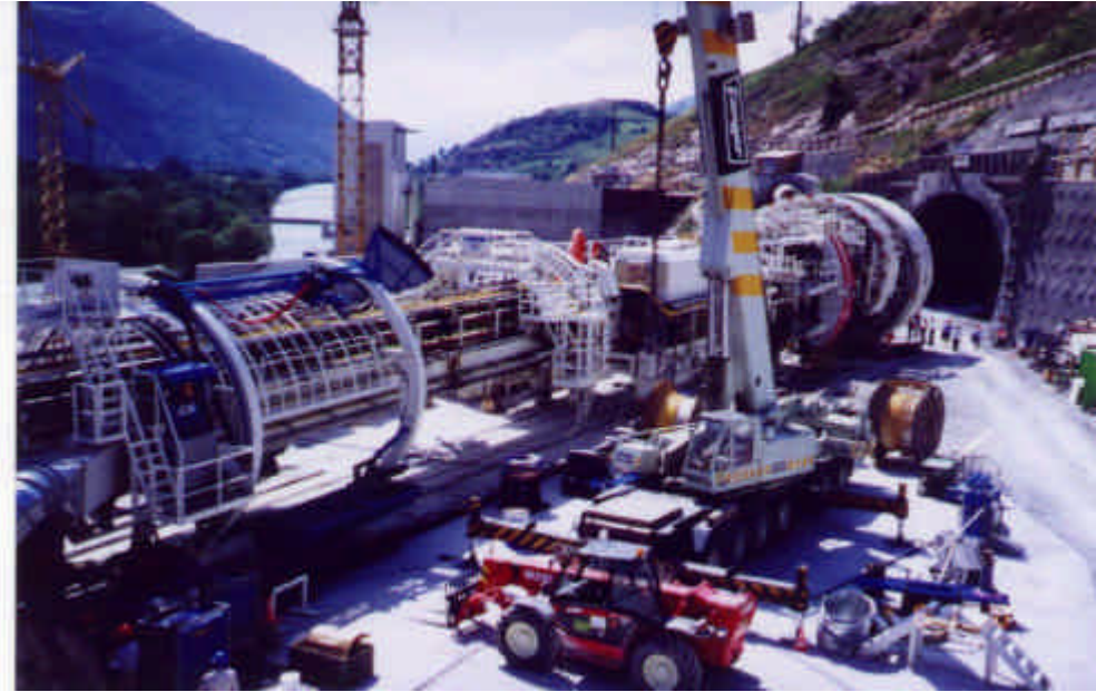
照片 5.6 組裝中之 TBM 機械
