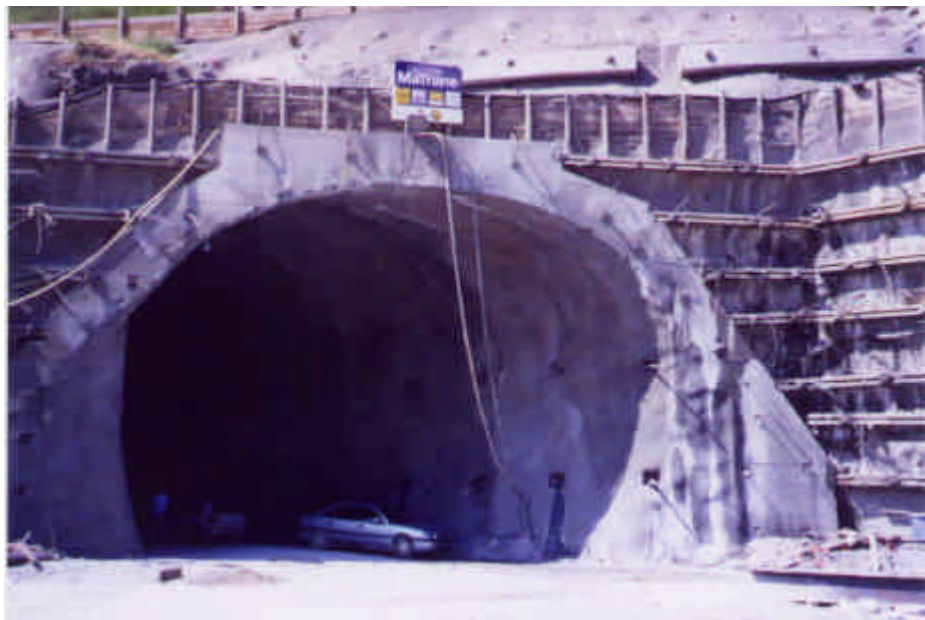
照片 5.7 洞口臨時保護側施
