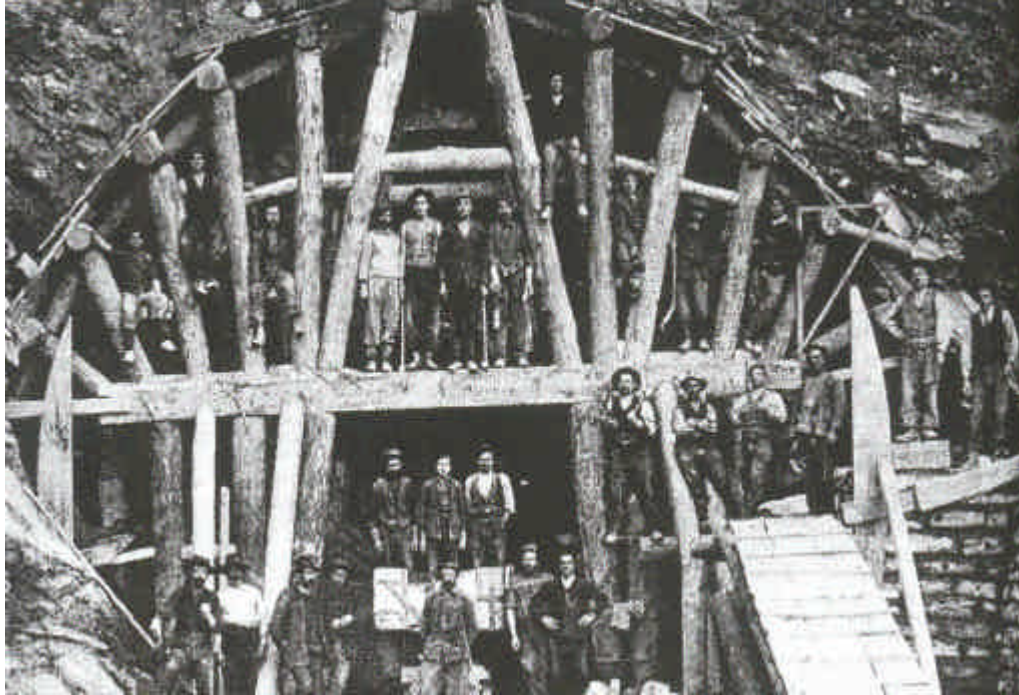
圖 3.6 Lotschberg 隧道南口使用木支撐
