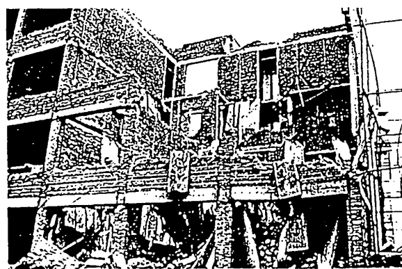
▲ 对工程结构的承载力、使用功能、耐久性评估，诊治已进行了数百项技术咨询服务，图为南通某厂综合楼倒塌事故技术鉴定
