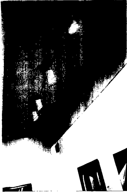
(圖二五) 室內裝置電軌可自由移動
