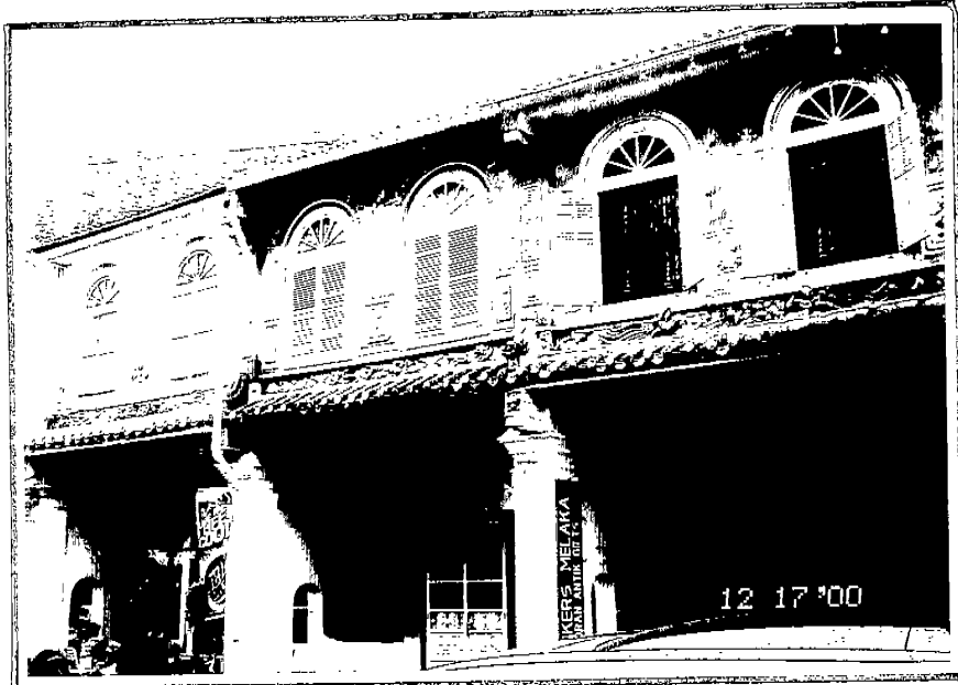
圖十九 麻六甲打金街粵式傳統民宅
