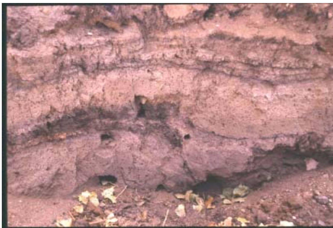
照片四 巴力溪槽溝開挖剖面局部呈現斷層(照片中央部份)切割左側厚層有黑色富有機物地層。
