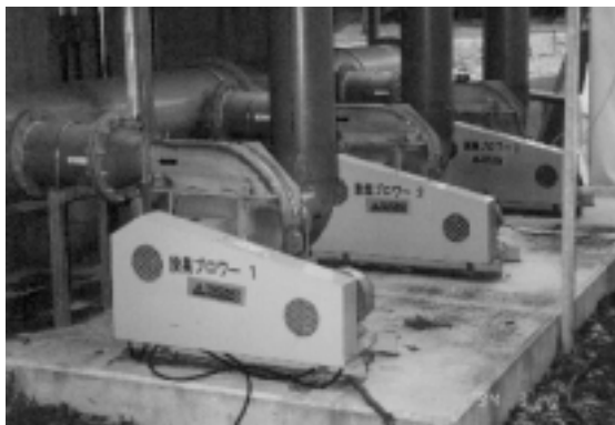
圖 15 脫臭用抽氣馬達(左)及脫臭槽(右)
