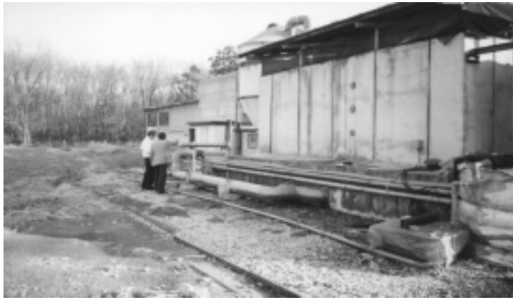
圖 19 石綿脫臭槽運作情形
