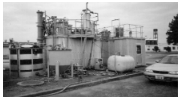
圖 9. UASB 養豬廢水處理規劃系統及實場操作
