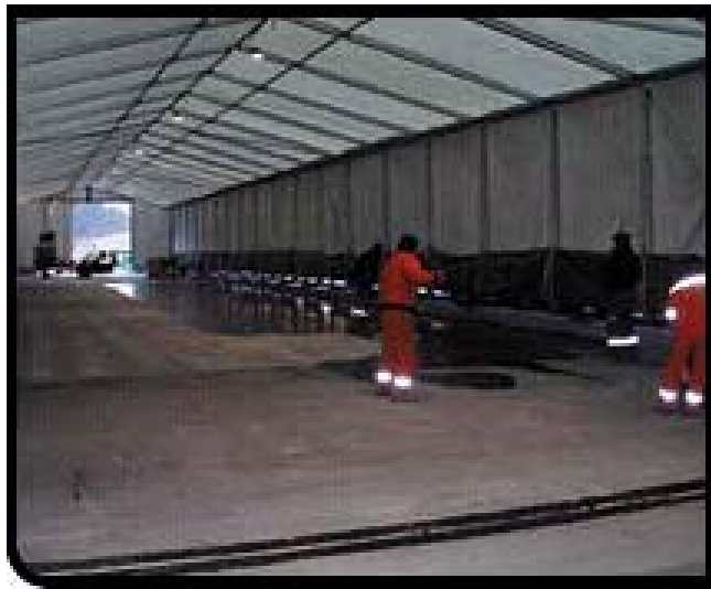
圖十四、橋面施工在活動式棚架下進行
