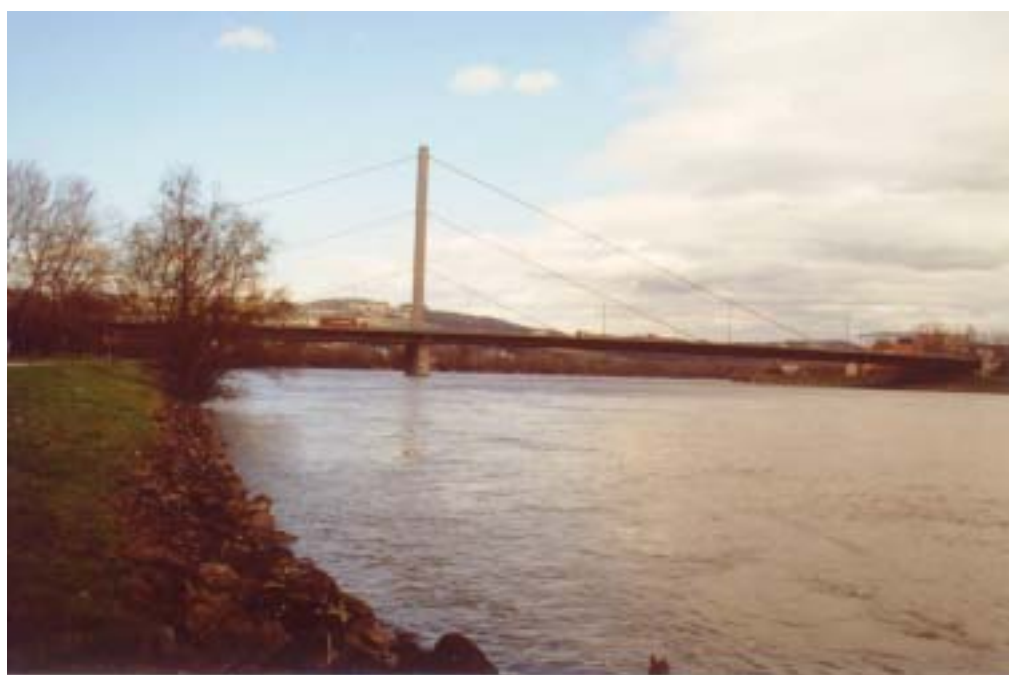
圖十七、A7高速公路於里茲市跨越多惱河之斜張橋
