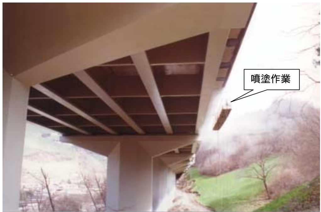
圖十六、橋梁表面噴漿情形及完成後表面外觀
