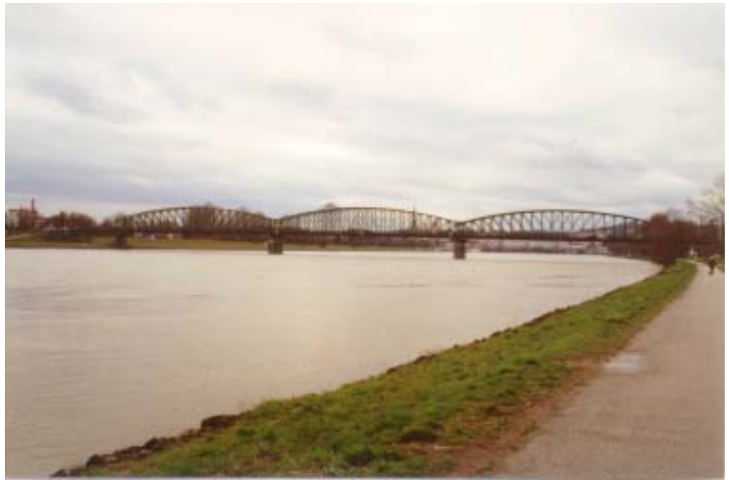
圖十八、里茲市區道路跨越多惱河之鋼桁架橋
