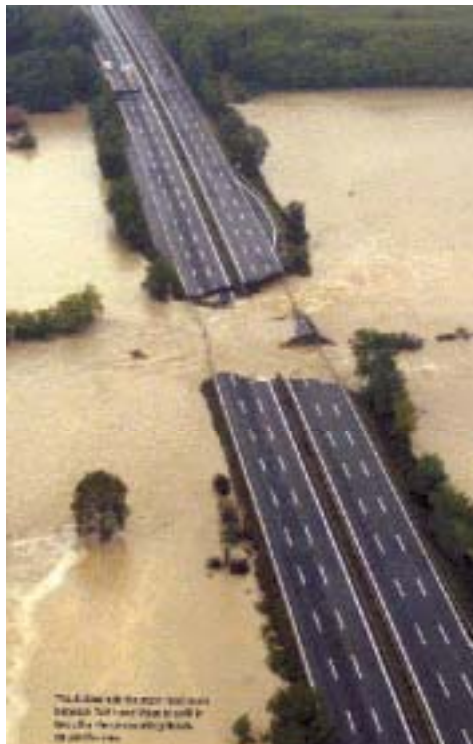
照片一 杜林~米蘭間高速公路被沖垮
