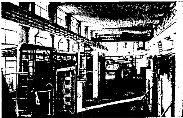
圖 3 天津消防研究所實驗室耐火爐設備
