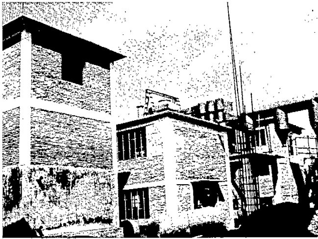
圖 29 抗震補強後之廠房
