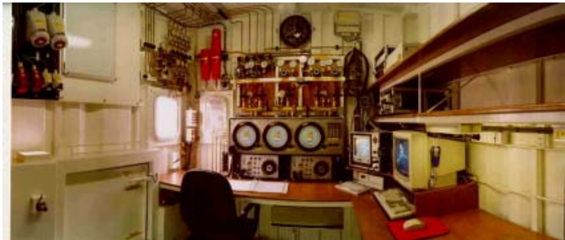
圖 6 HOORDHOEK 公司飽和潛水控制室內部
