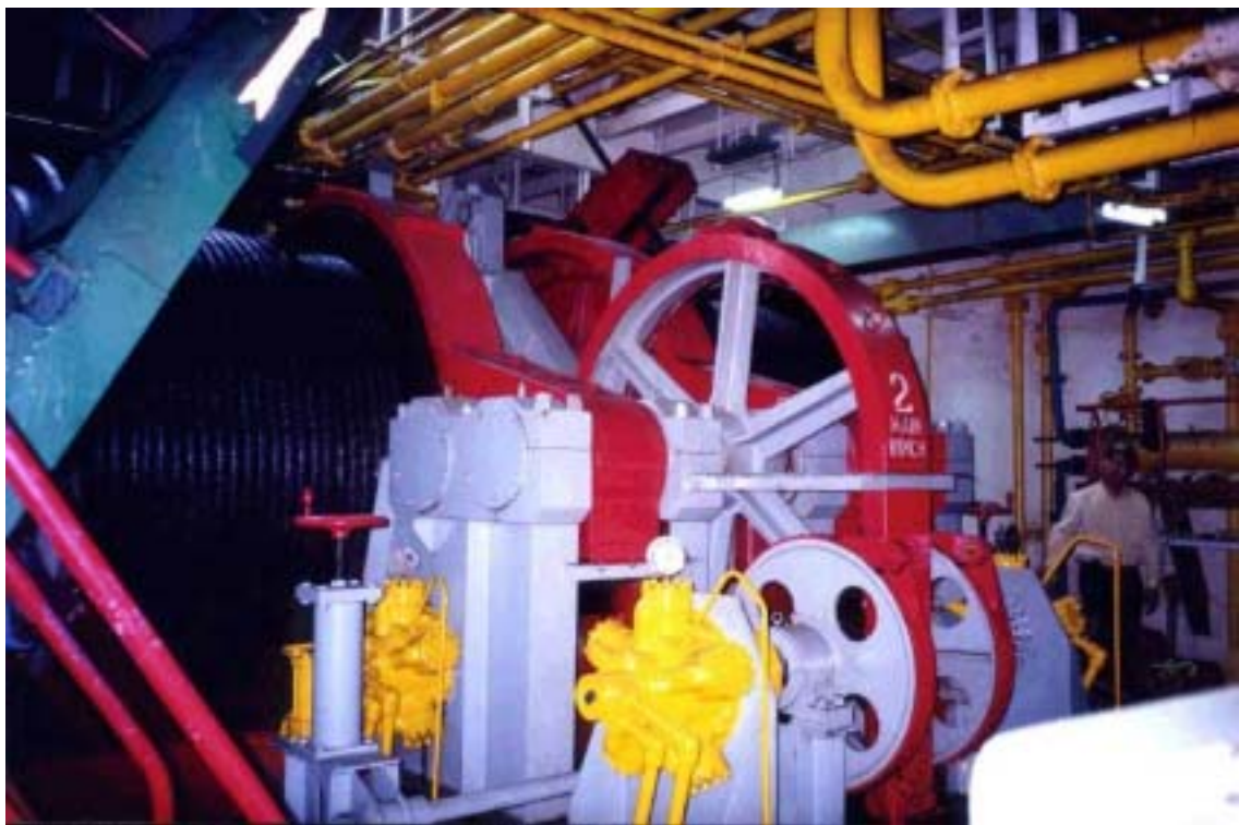
圖 4 L-1501 起重駁船之 Main Winch
