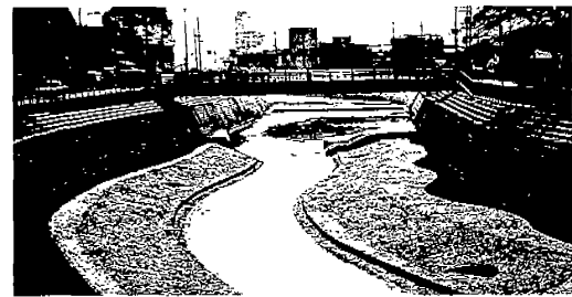
渾濁流浄化施設
