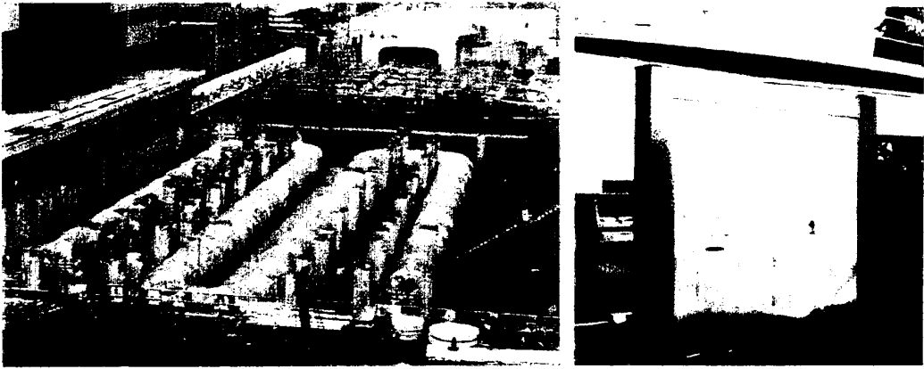
圖 1-8 MM21 基礎施工中之防災循環儲水槽 可供應五十萬人三日份緊急用水。
