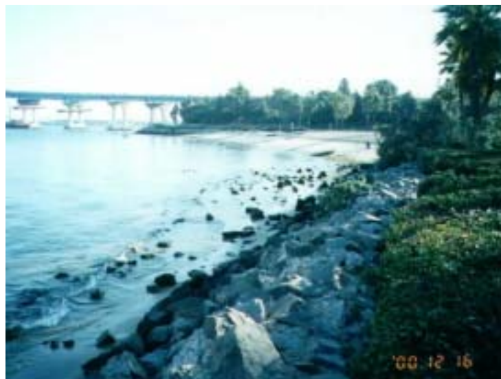
圖 9-3 Coronado 跨海大橋西端潮間帶公園
