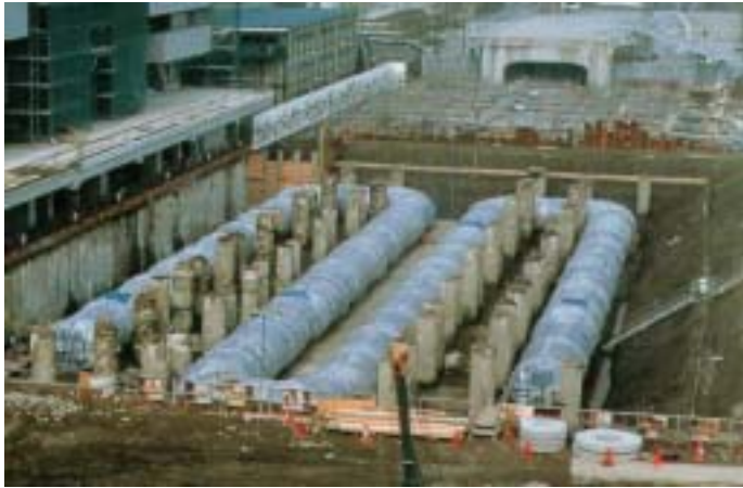
圖 1-8 MM21 基礎施工中之防災循環儲水槽 可供應五十萬人三日份緊急用水。
