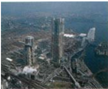
圖 1-6 1994 橫濱新港市空中俯瞰照，地標大樓施工中。
