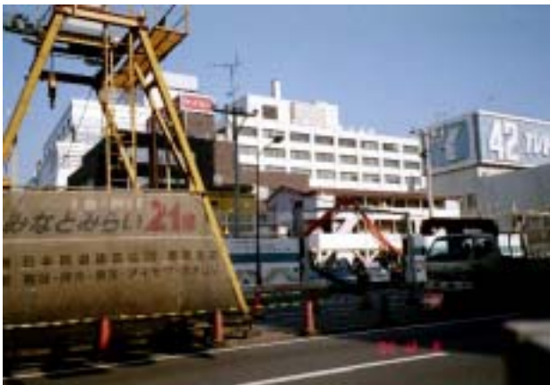
圖 3-3 JR MM21 線北仲通地區市區地下工程施工，道路外之場站除工務所臨時辦公室外，以最小空間同時提供停車施工灌漿，道路部分亦盡量減少使用道路面積，減少對原道路之交通衝擊。
