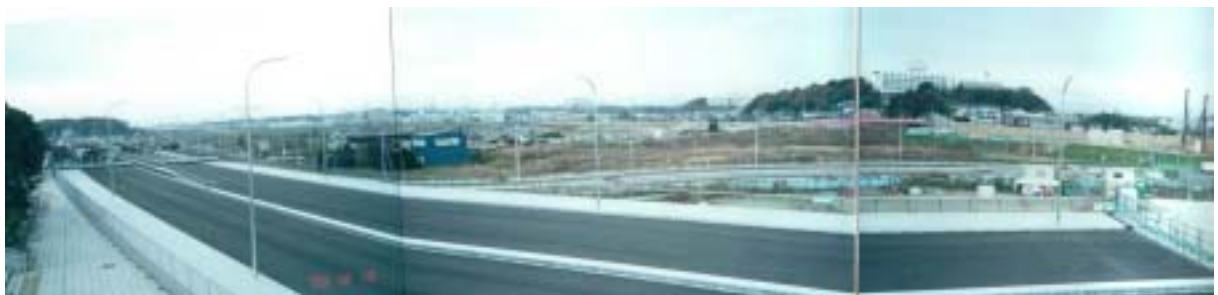
圖 2-12 新橫濱國際綜合競技場側高架快速道路； 右側路段工程仍施工中，左側局部完工路段提供作跳虱市場。
