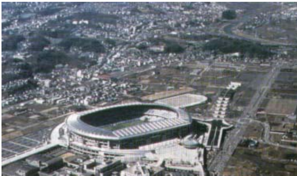
圖 2-6 自新橫濱站俯瞰橫濱國際綜合競技場，高架道路施工中
