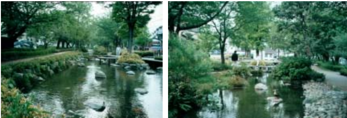
圖 3-6 市區自然生態工法施工之水渠景觀一
