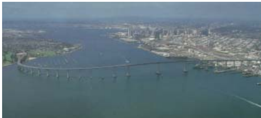
圖 9-2 San Diego 海灣兩岸間 75 號跨海大橋
