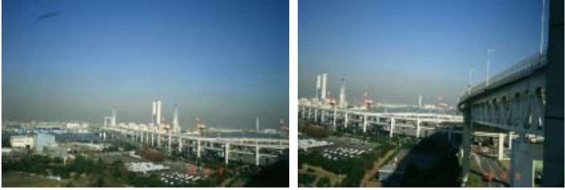
圖 3-12 空中步道北眺橫濱羽田快速道路支線匝道
