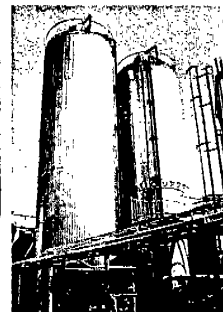
高負荷型嫌気処理設備
