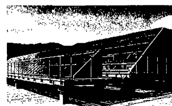
伊那事業所 太陽光パネル
