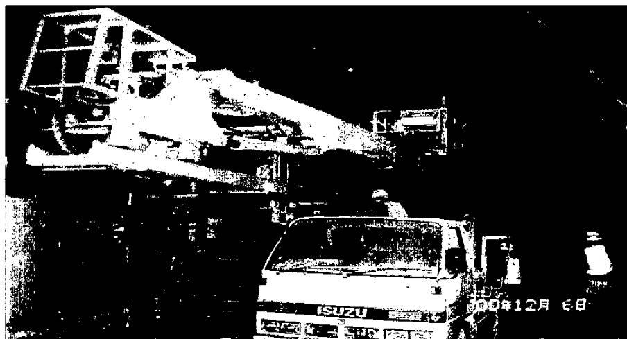
照片五、箕面隧道噴凝土施作情形
