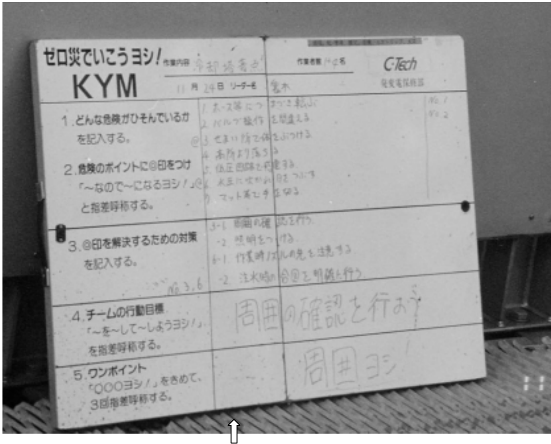
主變壓器冷却器(位於頂樓)於維修時之工安看板： 預知危險活動內容
