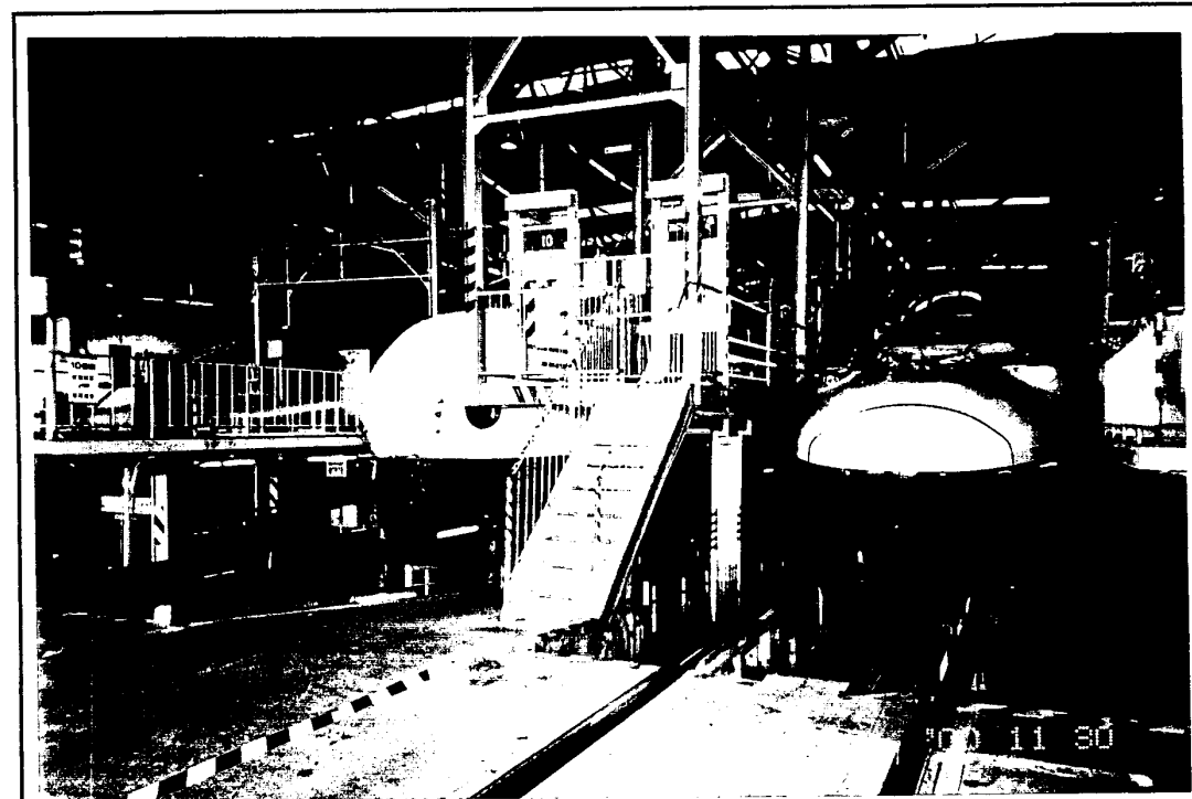
維修平台管制門
