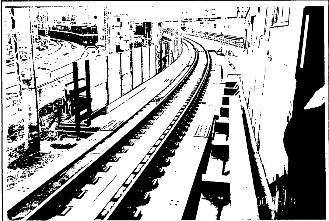
工程梁柱托底之軌道(一)
