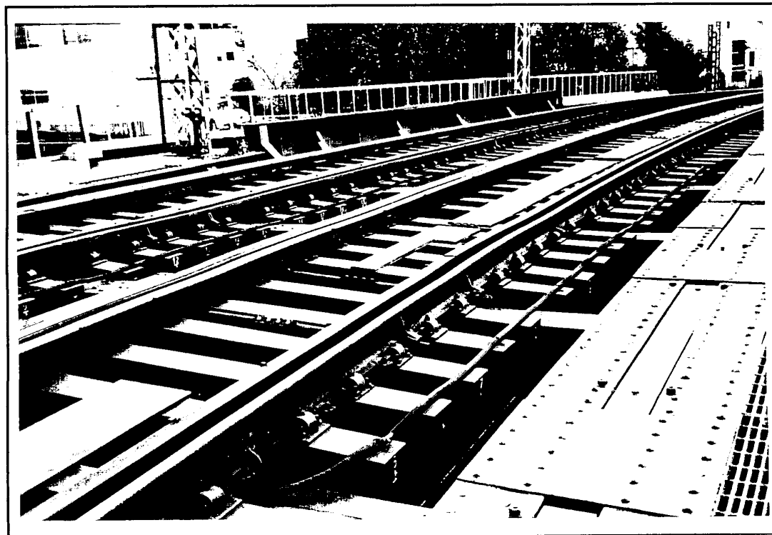
工程梁柱托底之軌道(二)
