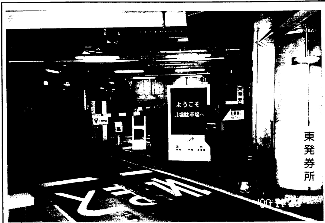
地下停車場自動停車取票設備
