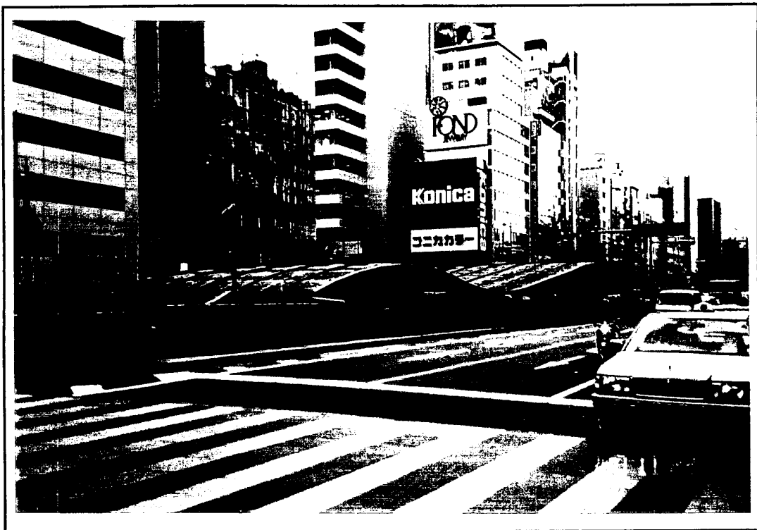
地面天窗造型兼自然排煙
