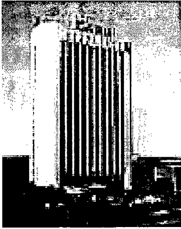
圖十三 建科院大樓
