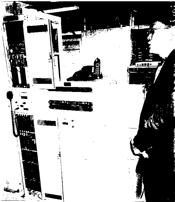
新大阪綜合調度所機電室
