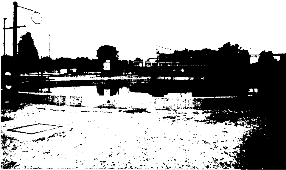
英國 Oxford 污水處理廠初沉池採地下化設計
