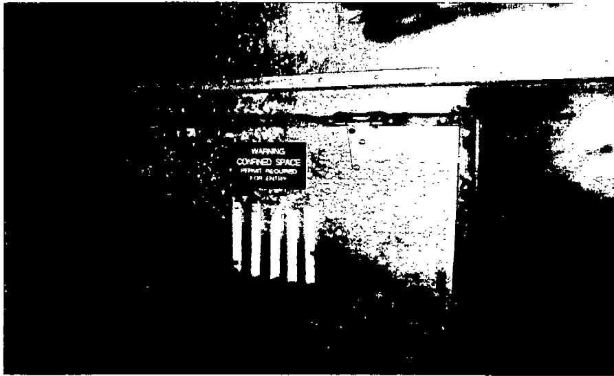
圖十五、現場對狹窄通風道之標示
