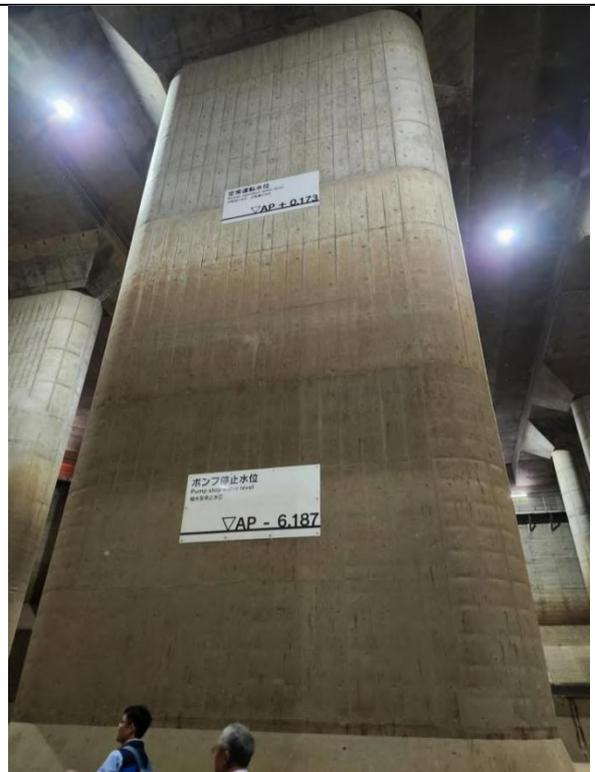
調壓水槽重達500噸的混凝土柱支撐
